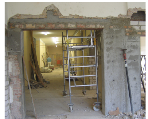
Umbauarbeiten im Erdgeschoss
